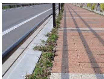
愛知県内歩道 (ブリックエッジ)
