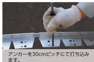
アンカーを30cmピッチにて打ち込みます。
