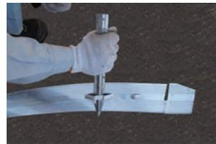
アンカー用スリットにアンカーを差し込み、打ち込みます。
