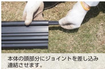
本体の頭部分にジョイントを差し込み連結させます。
