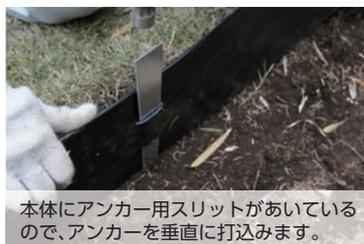
本体にアンカー用スリットがあいているので、アンカーを垂直に打込みます。
