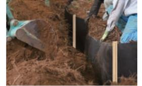
樹木などの支柱を使用し、シートを固定します。その後、土を埋め戻します。
