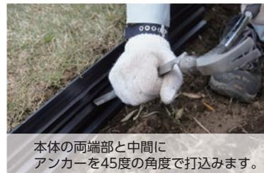
本体の両端部と中間にアンカーを45度の角度で打込みます。
