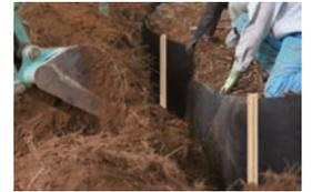
椀木などの支柱を使用し、シートを固定します。その後、土を埋め戻します。
