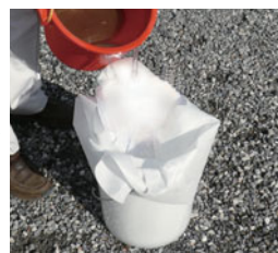
⑥凝集したモルタル水で、きれ いな上澄み部分をペール缶に 流し込む。
