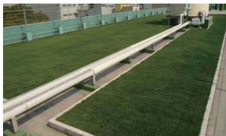
鹿児島県内小学校屋上
